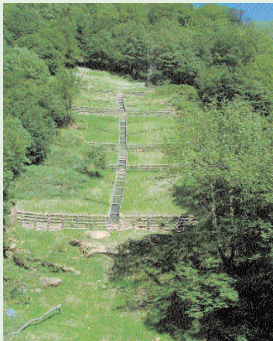
Area in frana (Versilia) stabilizzata con palificate doppie in legname e talee di salice, canaletta in legname e geosintetico tridimensionale, biostuoia antierosiva ed inerbimento con idrosemina (Foto Trigila).
