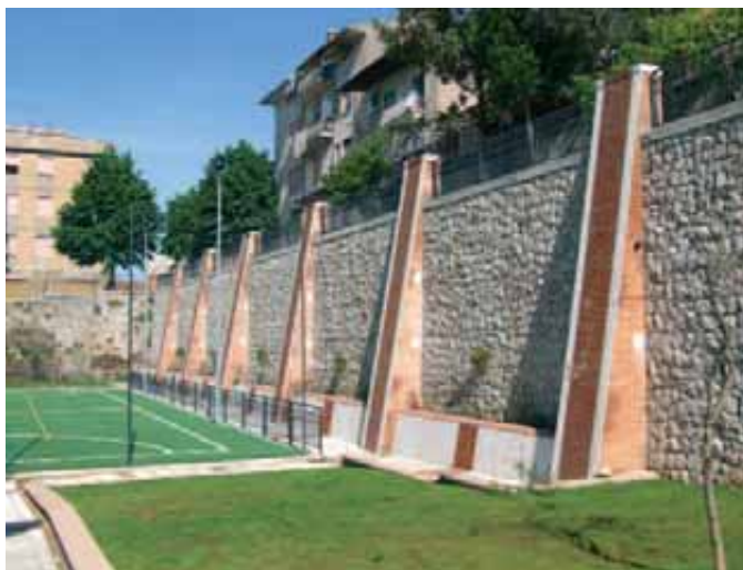
Muro controterra in c.a. rivestito in pietra calcarea con l'inserimento di speroni rivestiti in mattoncino di cotto ed elementi di travertino
