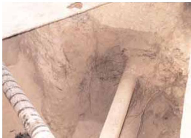
Sottoservizi nei pressi di alberi
